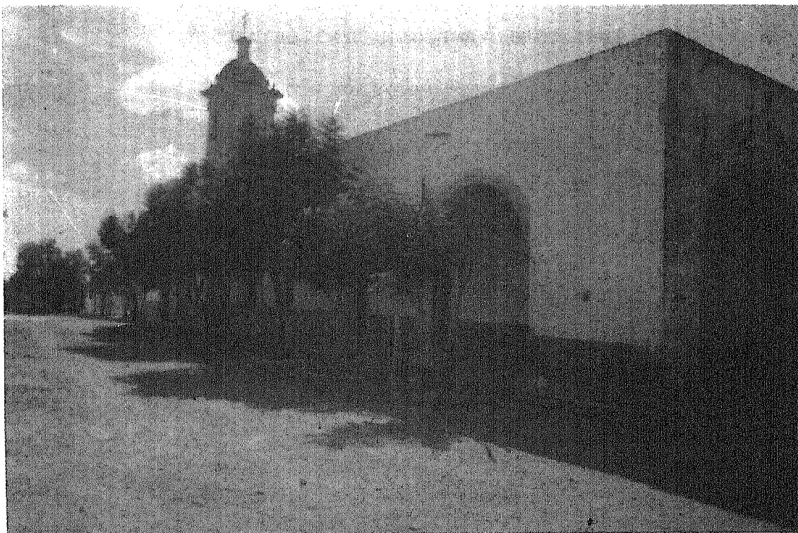
ANTIGUA "CASA GRANDE" DE LA HACIENDA DE LA TROJITA, DE GRUESOS MUROS Y ALTAS ARQUERÍAS Y PORTONES DE GRUESAS MADERAS QUE RESISTEN EL PASO DE LOS AÑOS.
