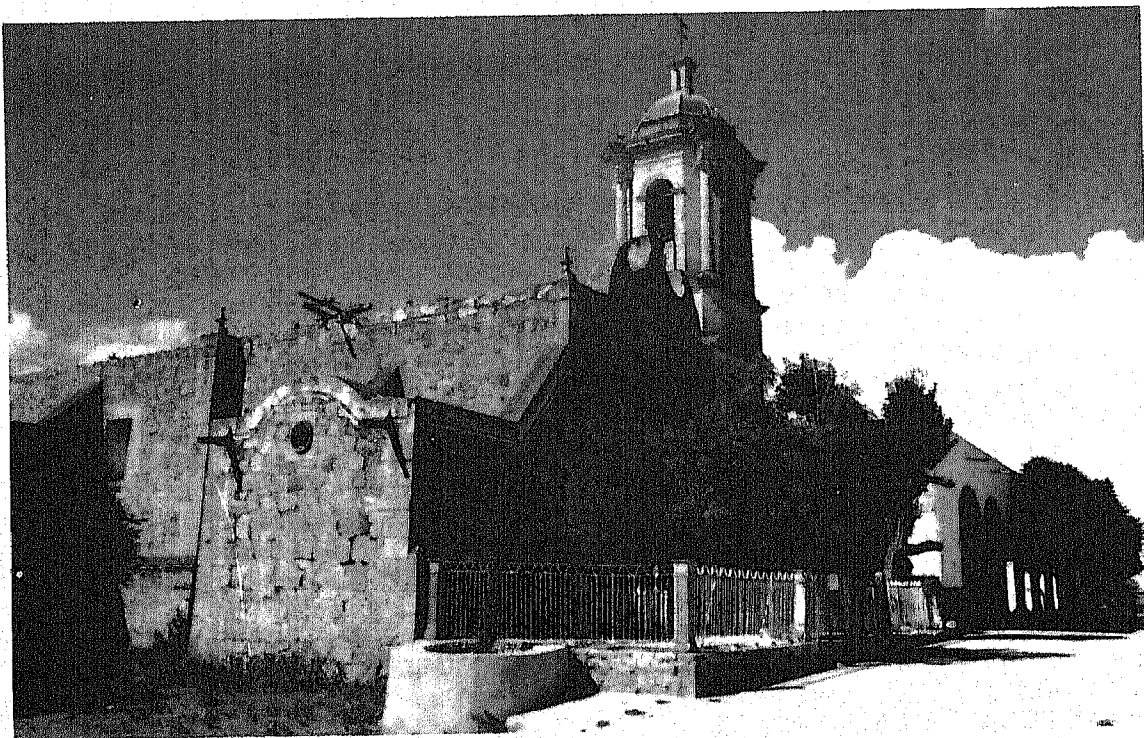
IGLESIA DE LA TROJITA, CONSTRUIDA DE GRUESOS MUROS DE CANTERA.
